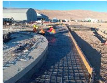
RINCÓN Ltd. 3 kTPA Rapid Plant – Fundaciones Edificios y Equipos | 2023-2024 BSD-GECO
